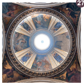
Chapelle du Très Saint Sacrement, de forme trapézoïdale, ornée de fresques et surmontée d'un petit dôme
